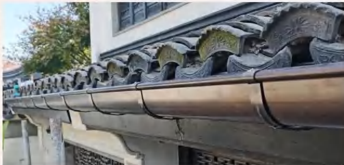
仿古镀铜天沟，代替原有PVC白色雨水管。
